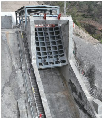
重型闸门快速启闭装置
