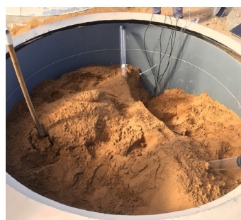
蒸渗仪土壤回填
