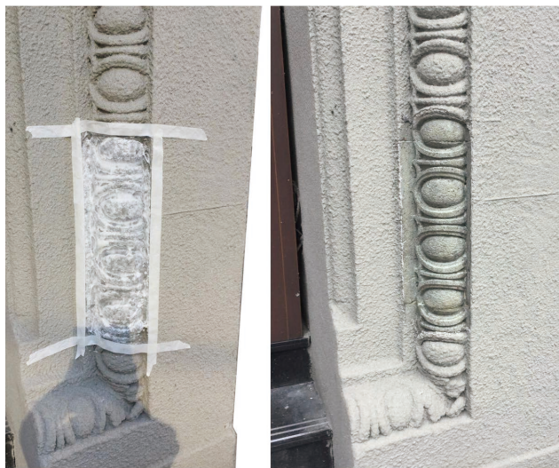
图 6 上海某历史建筑采用新型脱漆膏去除真石漆的效果
