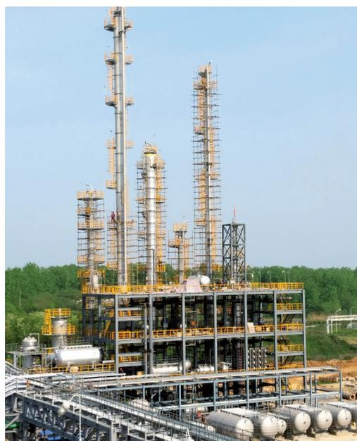
3万吨/年离子液体催化 $\text{CO}_2$ 转化合成DMC/EG工业装置
